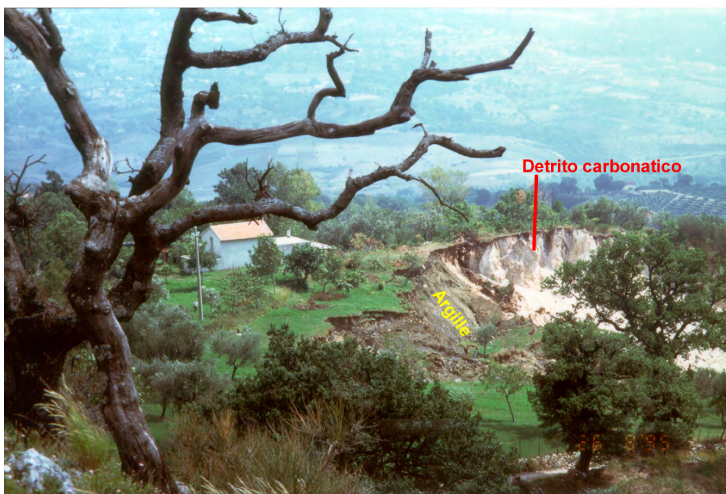
Figura 2.07 - Vista dall'alto della corona della Frana Vadoncello del 1993
